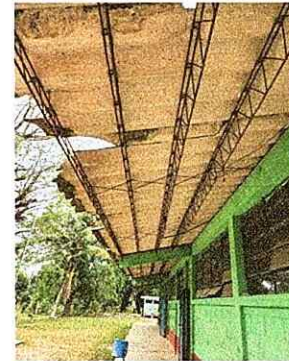
Foto 2: Estructura y cubierta de Lamina en mal estado, con filtracion de agua en el aula
